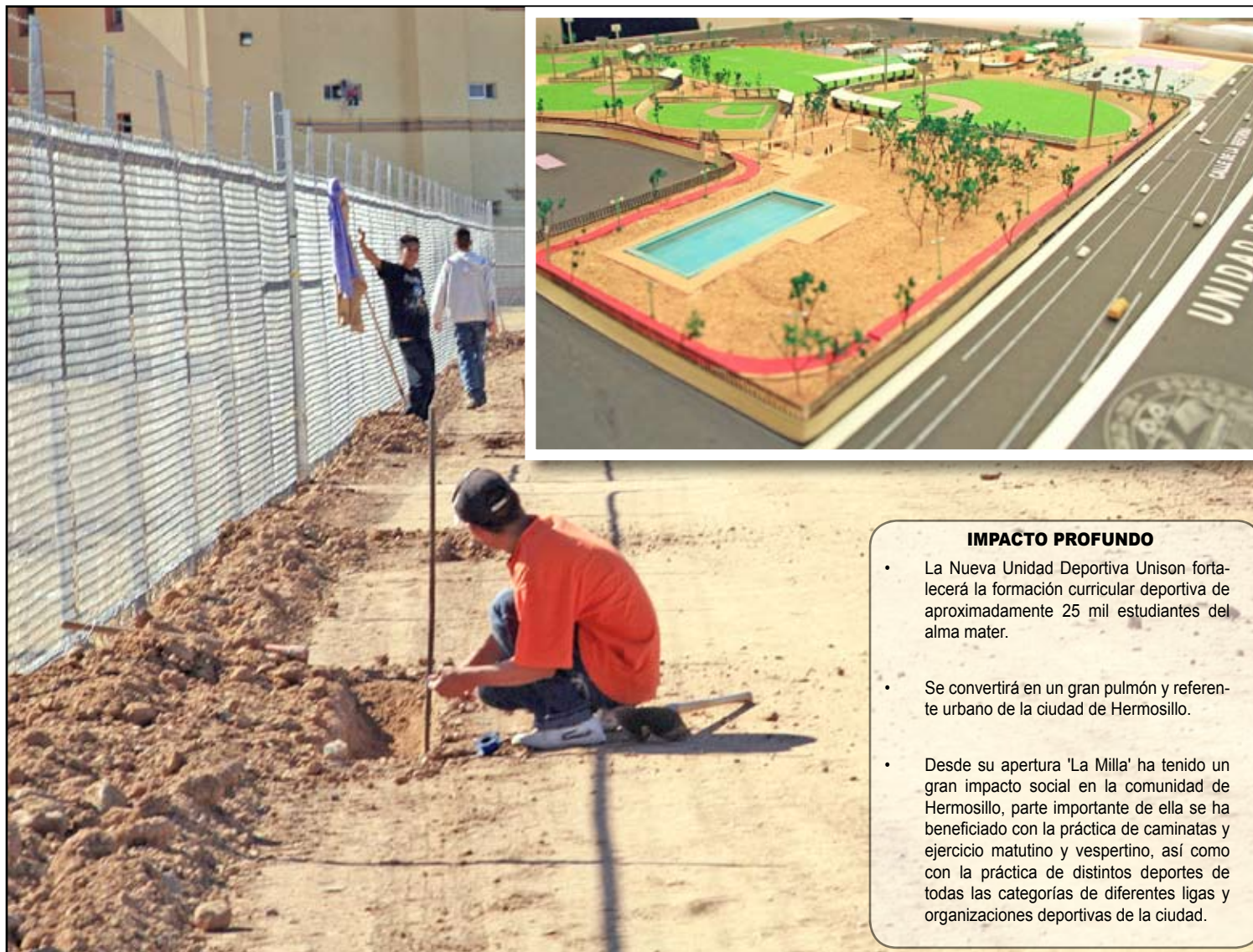
Trabajadores realizan excavaciones sobre la superficie actual de la pista de 'La Milla'; en la imagen de arriba se aprecia de la maqueta de la Unidad Deportiva Unison.
