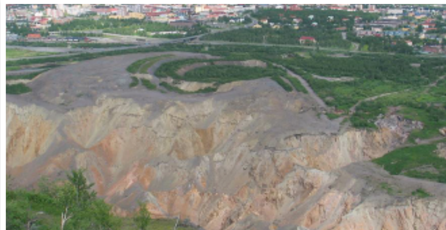
Efecto en superficie del método de explotación (hundimiento por subniveles) en la Mina Kiirunavaara, ubicada a 145 kilómetros del círculo polar ártico, en la ciudad de Laponia.
