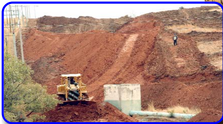
El ritmo de construcción de las obras muestra buen avance
